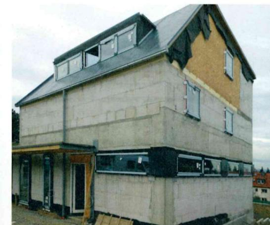
Links unten: Rohbau: Erd- und Obergeschoss bestehen aus Kalksandstein und Beton, das Dachgeschoss an der Vorderseite ist ein Holzrahmenbau
