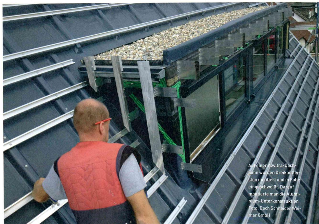
Auf einer Alwitra-Dachbahn wurden Dreikantleisten montiert und in Folie eingeschweißt. Darauf montierte man die Aluminium-Unterkonstruktion
