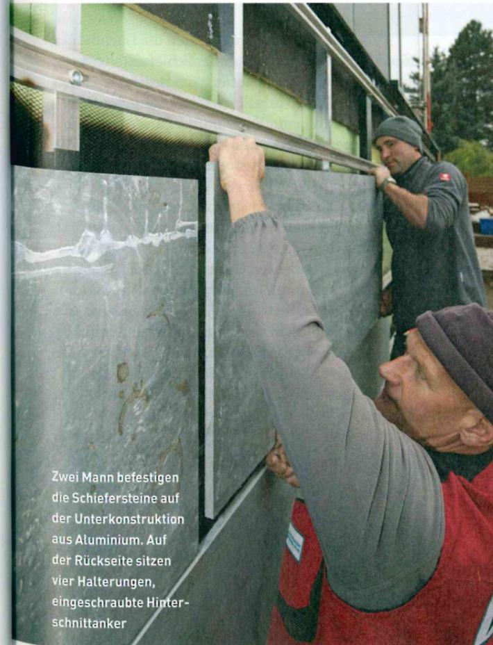
Zwei Mann befestigen die Schiefersteine auf der Unterkonstruktion aus Aluminium. Auf der Rückseite sitzen vier Halterungen, eingeschraubte Hinterschnittanker
