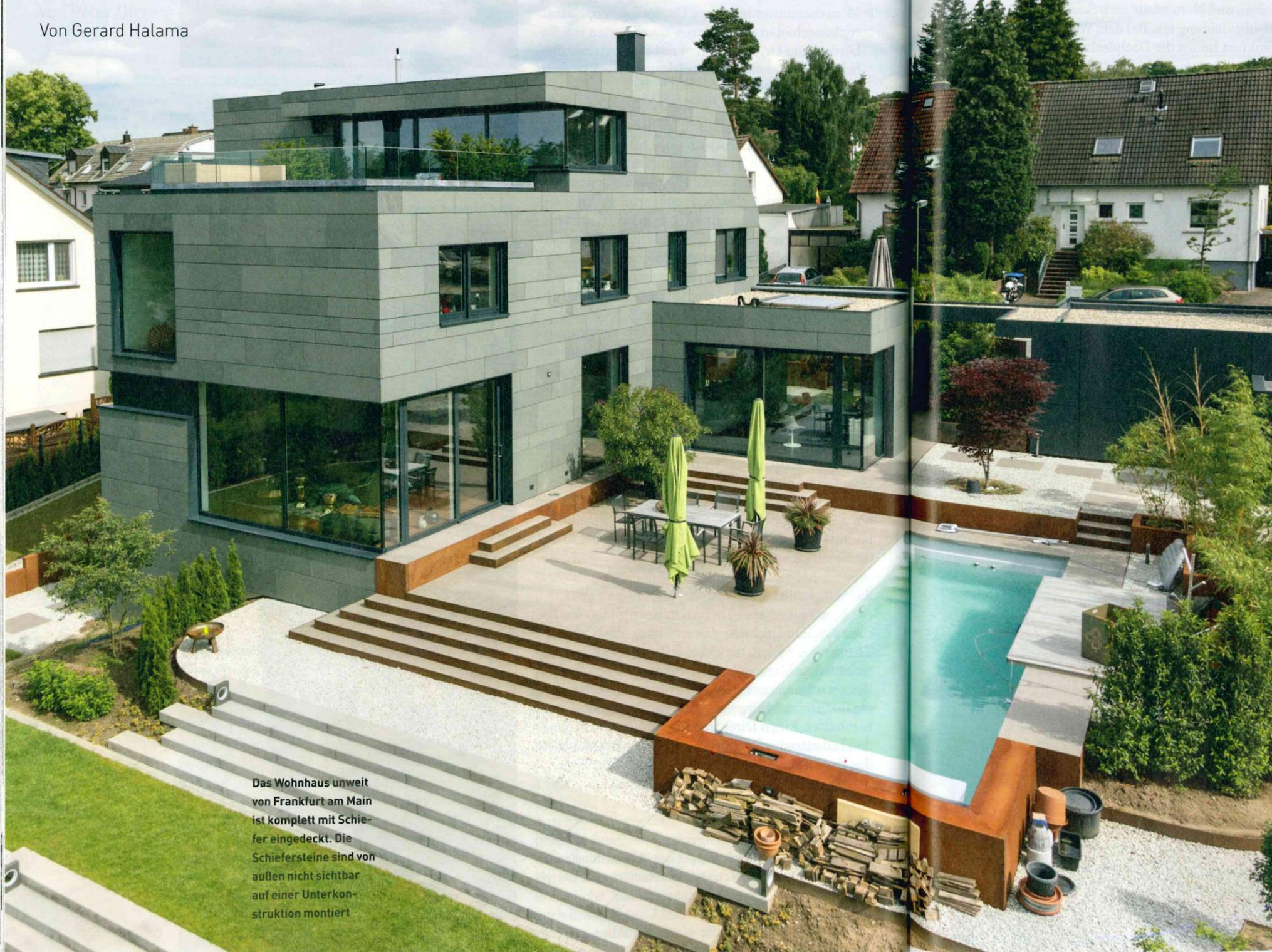
Das Wohnhaus unweit von Frankfurt am Main ist komplett mit Schiefer eingedeckt. Die Schiefersteine sind von außen nicht sichtbar auf einer Unterkonstruktion montiert
