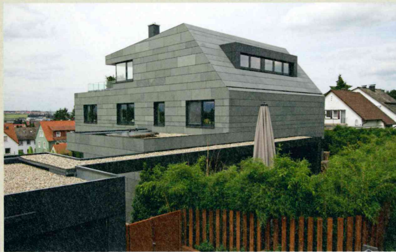
Fassaden und Dachfläche sind mit dem grünen Schiefer verkleidet und fügen die unterschiedlichen Elemente des Wohnhauses wieder zu einer Einheit zusammen
