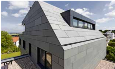
Schiefermonolith mit innenliegender Kastenrinne und Revisionsmöglichkeit
